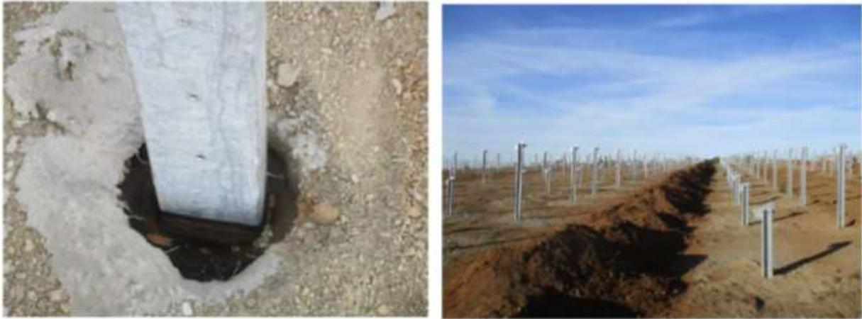
Figure 12 Exemple de fondation type pieux – O ENERGY France
