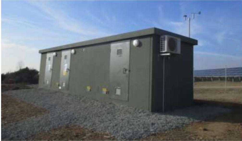
Figure 14 Exemple de structure de livraison – Q ENERGY France
